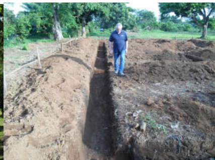
Mit dem zweiten Gebäude wurde begonnen
